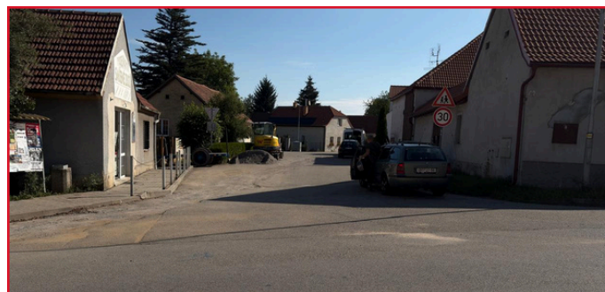
ulice okolo školy - prodloužení vodovodu
